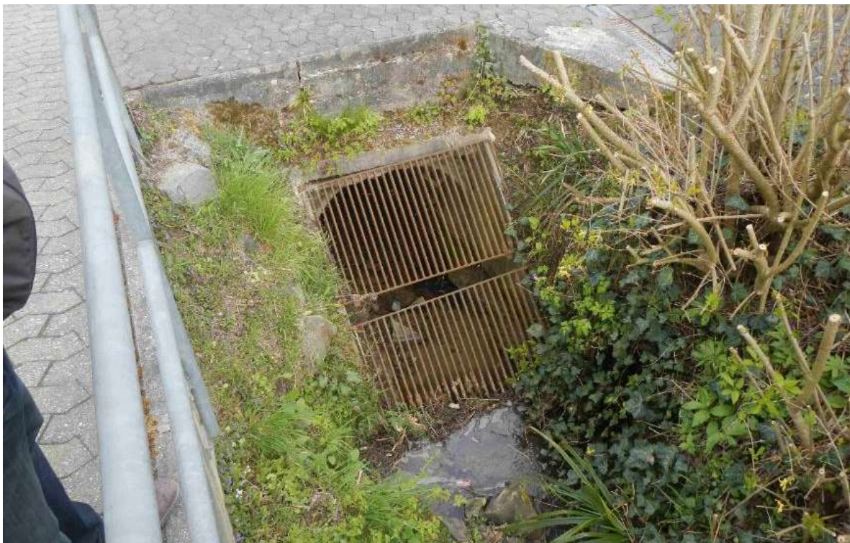
Abb. 5-31: Einlauf Verrohrung Siefen nahe Mehrzweckhalle (M12)
