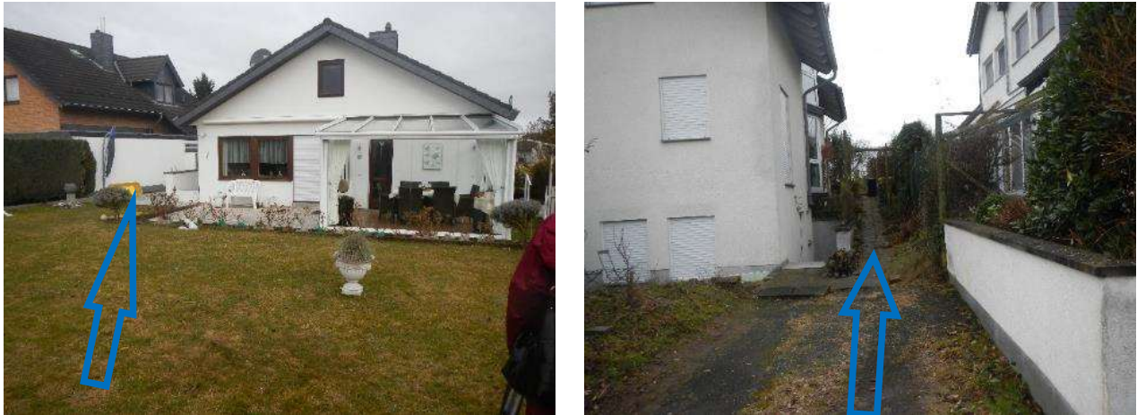
Abb. 5-16: Ableitungsmöglichkeiten zwischen Gebäuden bei Objektschutz (MX)
