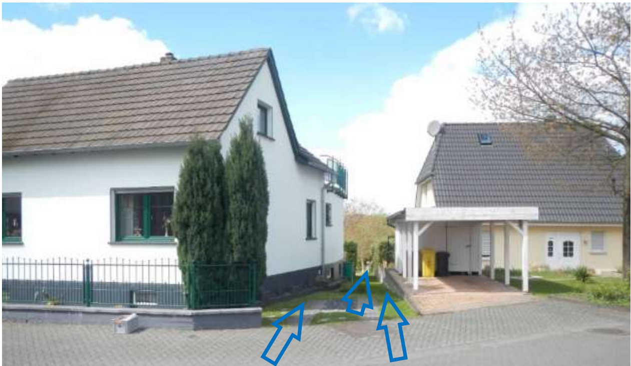
Abb. 5-23: Ableitung nahe Feuerwehrgerätehaus Oedingen –Erhalt Ableitungsweg (M9)
