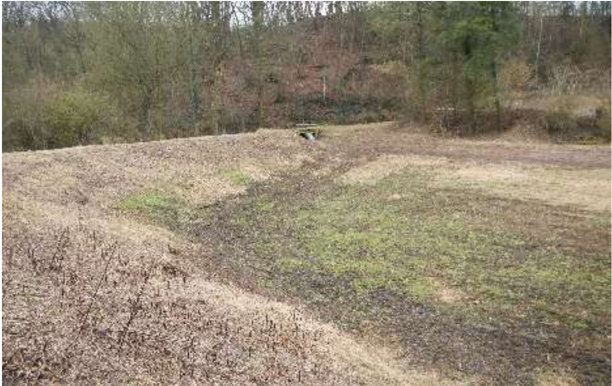
Abb. 5-39: Rückhalt Bandorfer Bach vor Stolleneinlauf (M16), realisiert
