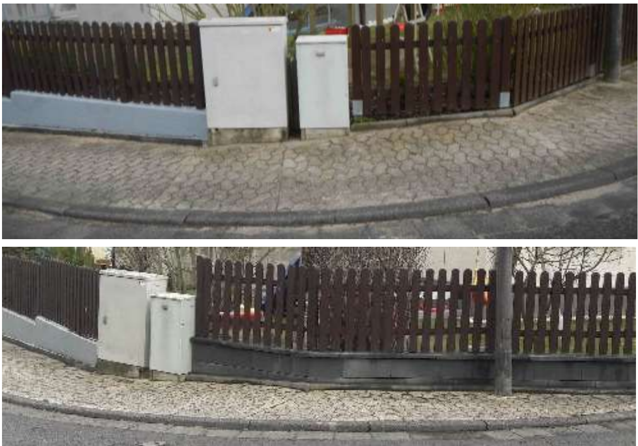
Abb. 5-17: Ecke Brückenweg/Kernbachweg (vorher: oben, nachher: unten) (M6, MX)
