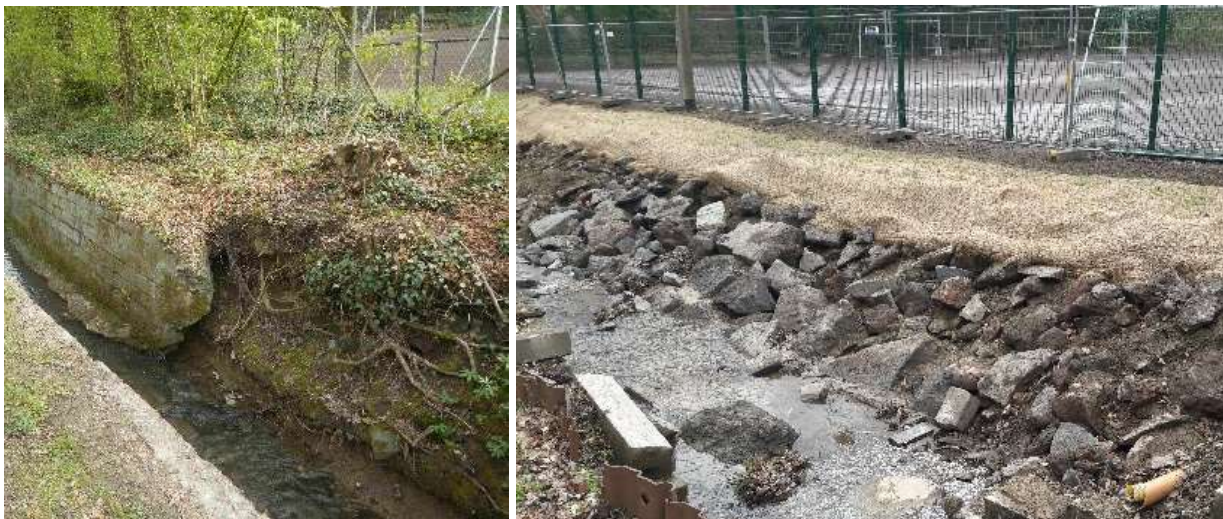
Abb. 5-40: Unkelbach, Unterlauf nahe Rheinstraße (M14), realisiert
