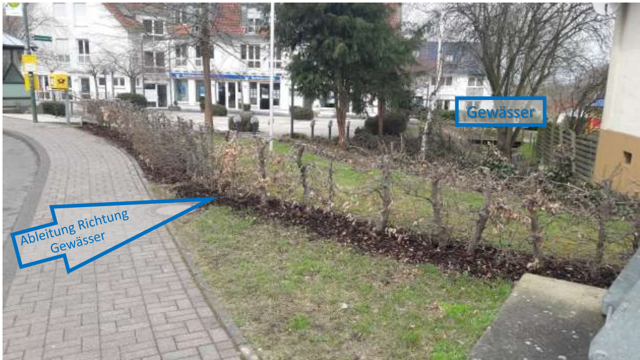
Abb. 5-20: Zuleitung vom Straßenraum in Richtung Gewässer (M8)
