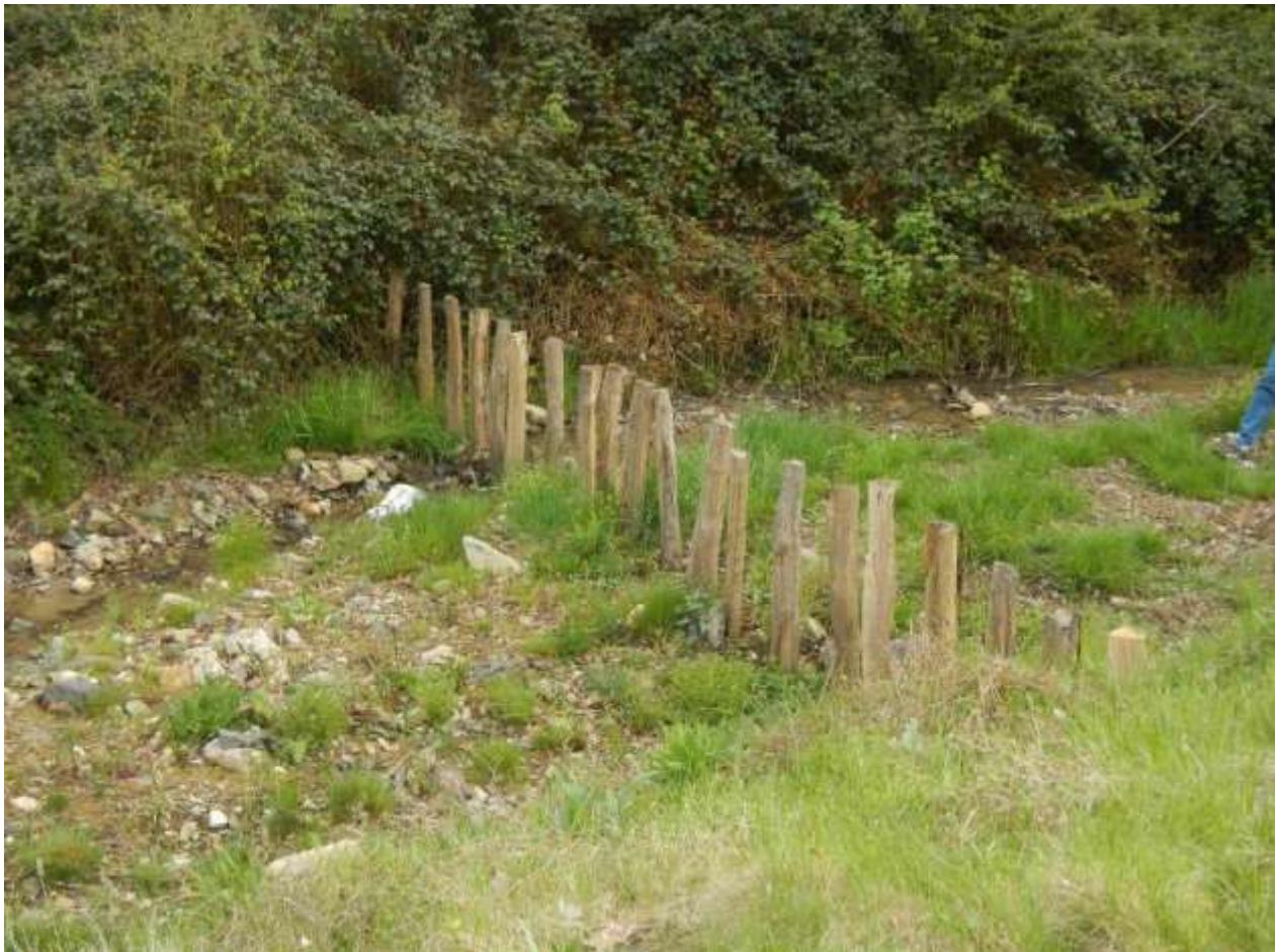
Abb. 5-28: Pfahlreihen zum Treibgutrückhalt (M11)
