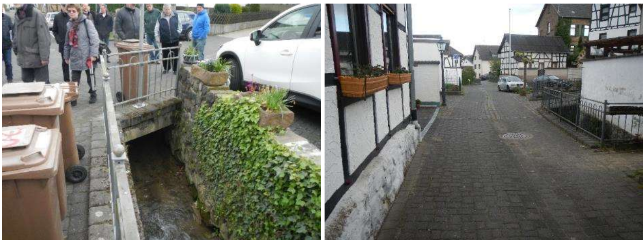
Abb. 5-36: Abflussengpass Unkelbach "Am Bach" (MX)
