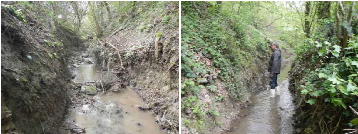
Abb. 5-38: Gewässereinschnitt Unkelbach Unterlauf (M14)
